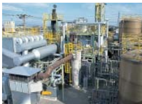
■MCRプラント：日本初の大規模陸上処理施設で、フィルム・写真廃液等の高温酸化処理を行います。
