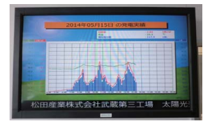
武蔵第3工場の太陽光発電システム
