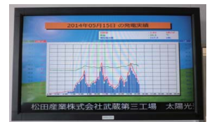
武蔵第3工場の太陽光発電システム
