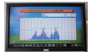
武蔵第3工場の太陽光発電システム
