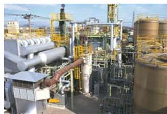
廃液濃縮・高温酸化処理設備 (MCRシステム)
