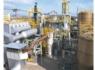
廃液濃縮・高温酸化処理設備（MCRシステム）
