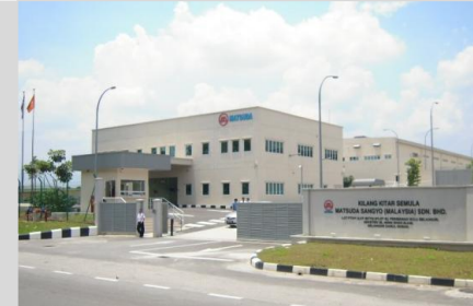
マレーシア工場
