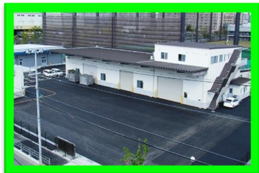
大阪ヤード(大阪府大阪市)
