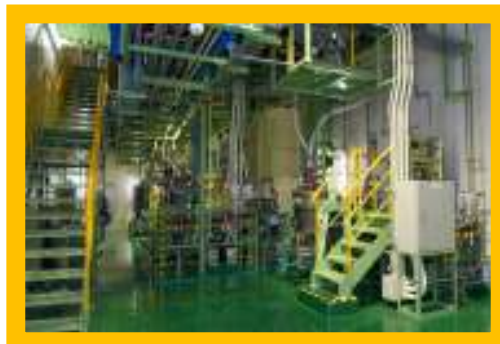
武蔵第3工場内部
