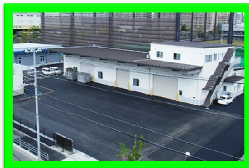
大阪ヤード(大阪府大阪市)
